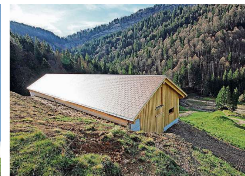
Auf dem «Ampferenboden» durfte die Brunner Holz Ideen GmbH einen neuen Alpstall realisieren. Die Zufahrt war nicht möglich. Dank der effizienten Vorarbeit der Zimmerleute und der sehr guten Zusammenarbeit mit der Firma Heli-Linth AG konnte der Alpstall in eineinhalb Stunden geflogen und aufgerichtet werden.
