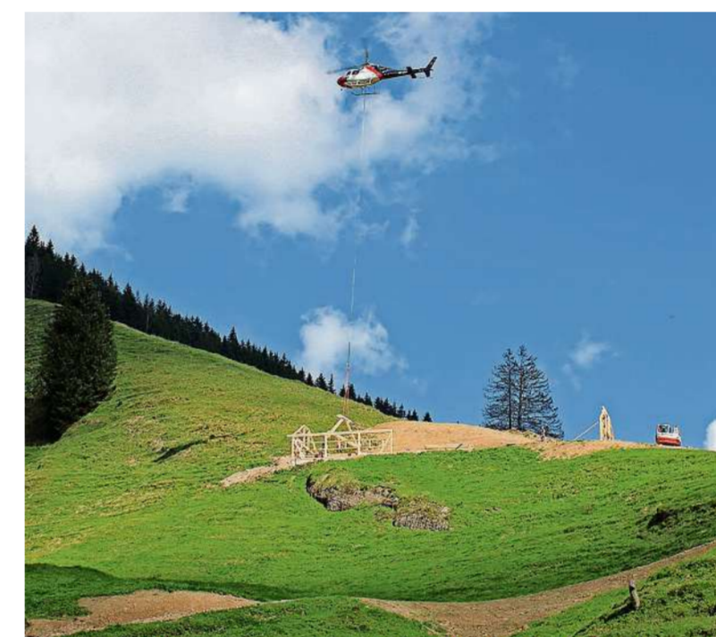
Auf dem «Ampferenboden» durfte die Brunner Holz Ideen GmbH einen neuen Alpstall realisieren. Die Zufahrt war nicht möglich. Dank der effizienten Vorarbeit der Zimmerleute und der sehr guten Zusammenarbeit mit der Firma Heli-Linth AG konnte der Alpstall in eineinhalb Stunden geflogen und aufgerichtet werden.
